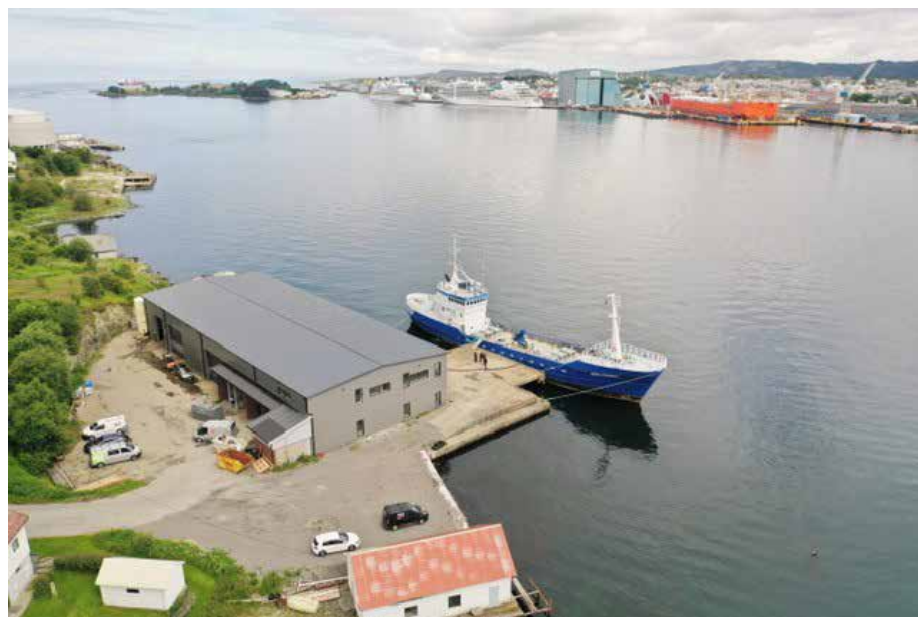
KARMØY: Miljøførfabrikken på Karmøy har dypvannskai, og salgsproduktet kan sendes med båt.
