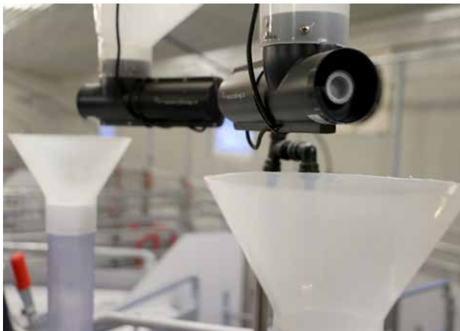
LUFT: Detaljer fra nedløpene i det trykkluftdrevne fôringsanlegget. Bildene er tatt i et annet grisehus, men viser anlegget slik det skal monteres.
